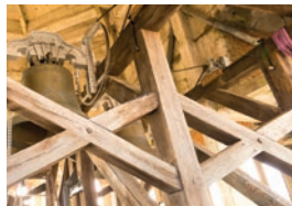
Restauration de beffrois
